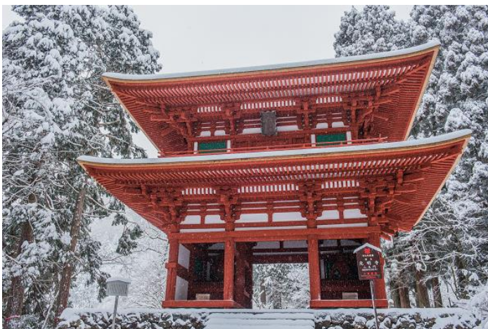
(冬：綾部市・京丹波町・亀岡市) 「冬の二王門」
